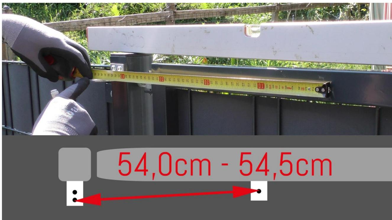
Passaggio 6: montaggio del secondo profilo angolare in alluminio
